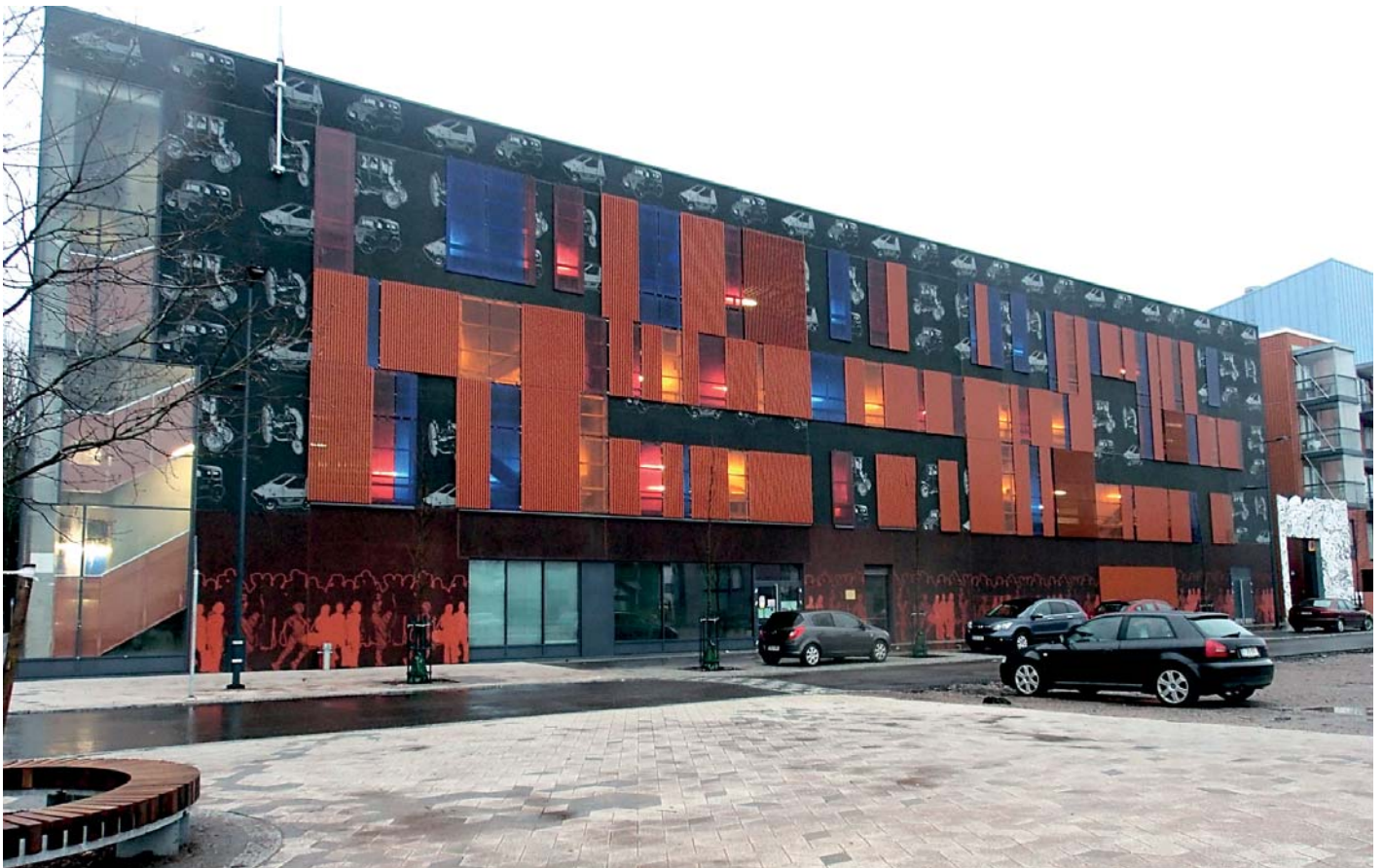
Pysäköintitalo voi olla julkisivunsa puolesta vaikka alueensa merkkirakennus. Kuva Vantaan Rubiinipakista.
