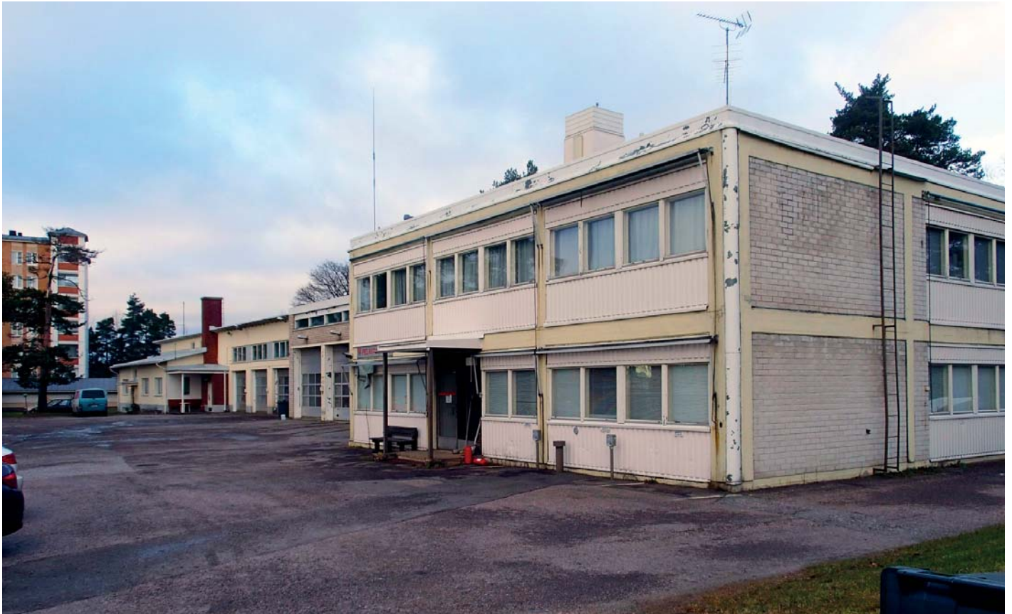
Vanha paloasemarakennus. Rakennus puretaan asuinkerrostalorakentamisen alta.
